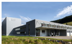
Logistické centrum společnosti Ganter
